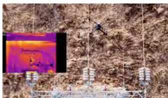
三峡能源甘肃武威智慧光伏场站无人机巡检
