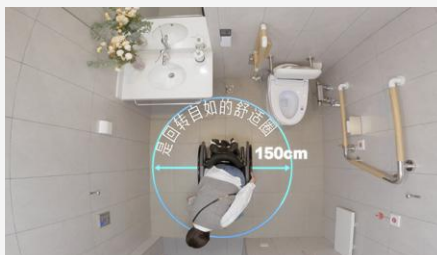
在无障碍卫生间，将留足直径为 150cm 的轮椅回转空间
