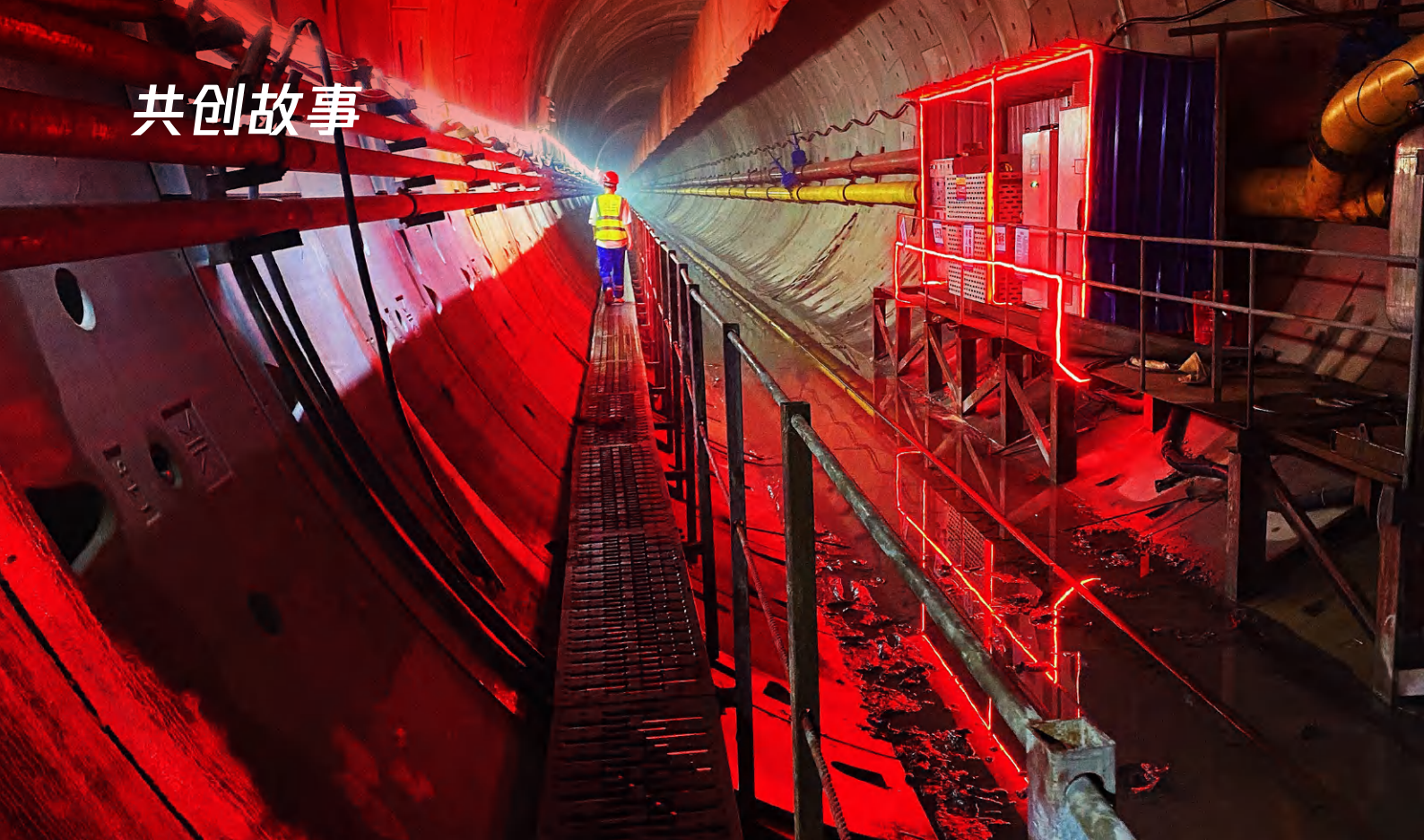
珠三角水资源配置工程现场
