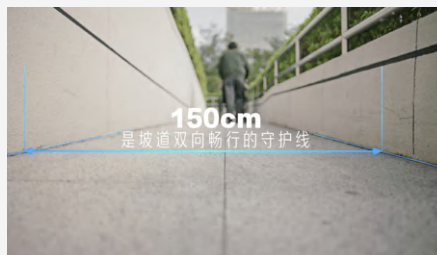
在轮椅坡道，净宽度将不小于 150cm，让轮椅车、婴儿车等顺畅并肩通行
